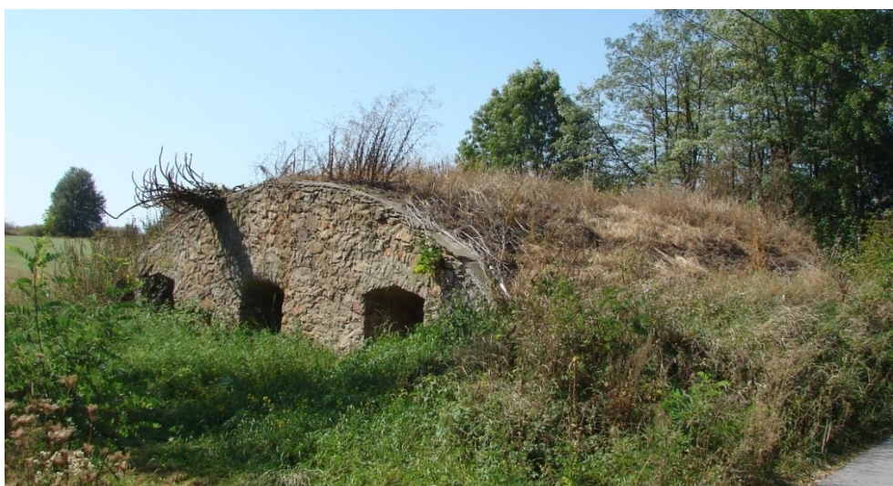
Murowana piwniczka ziemna w Zaborzu (prawdopodobnie pozostałość zespołu folwarcznego).
