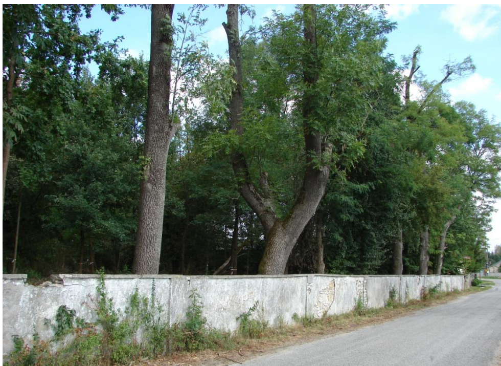
Park z ogrodzeniem w Drochowie Dolnym.
